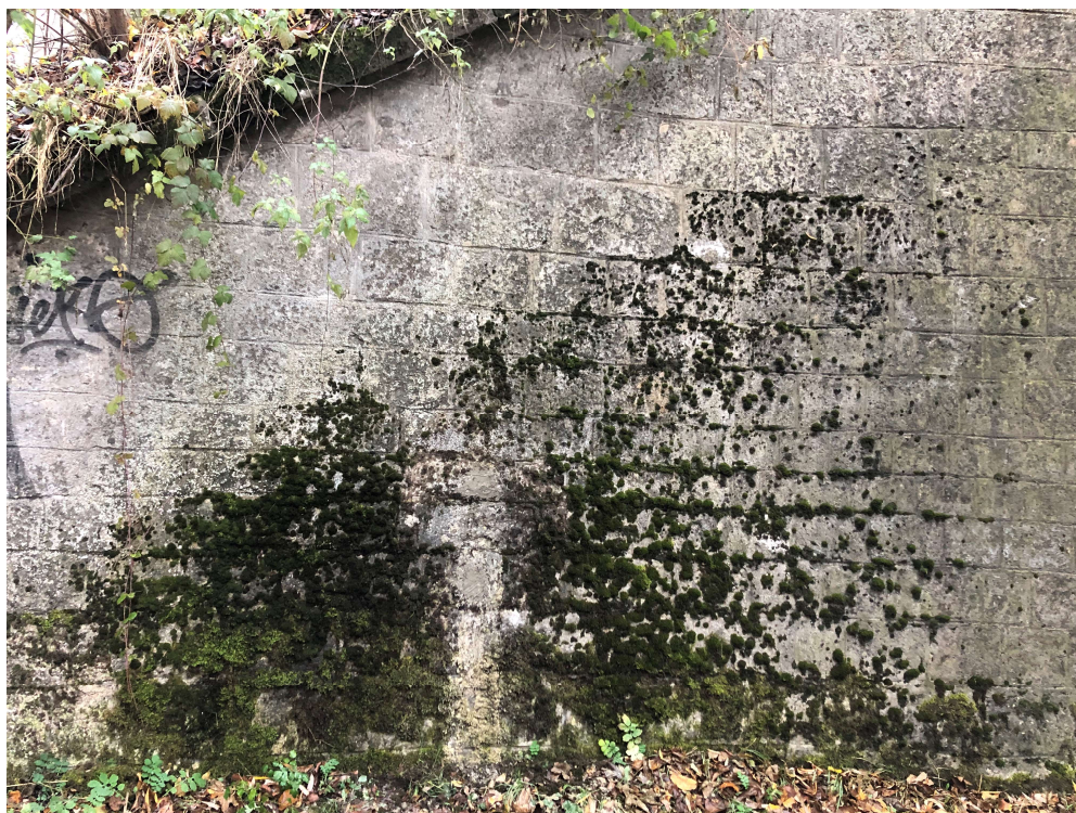
Fotografie č. 7: Pohled na pravé křídlo opěry ve směru na Brno hl. n. Místa degradované nebo vypadané spárování.
