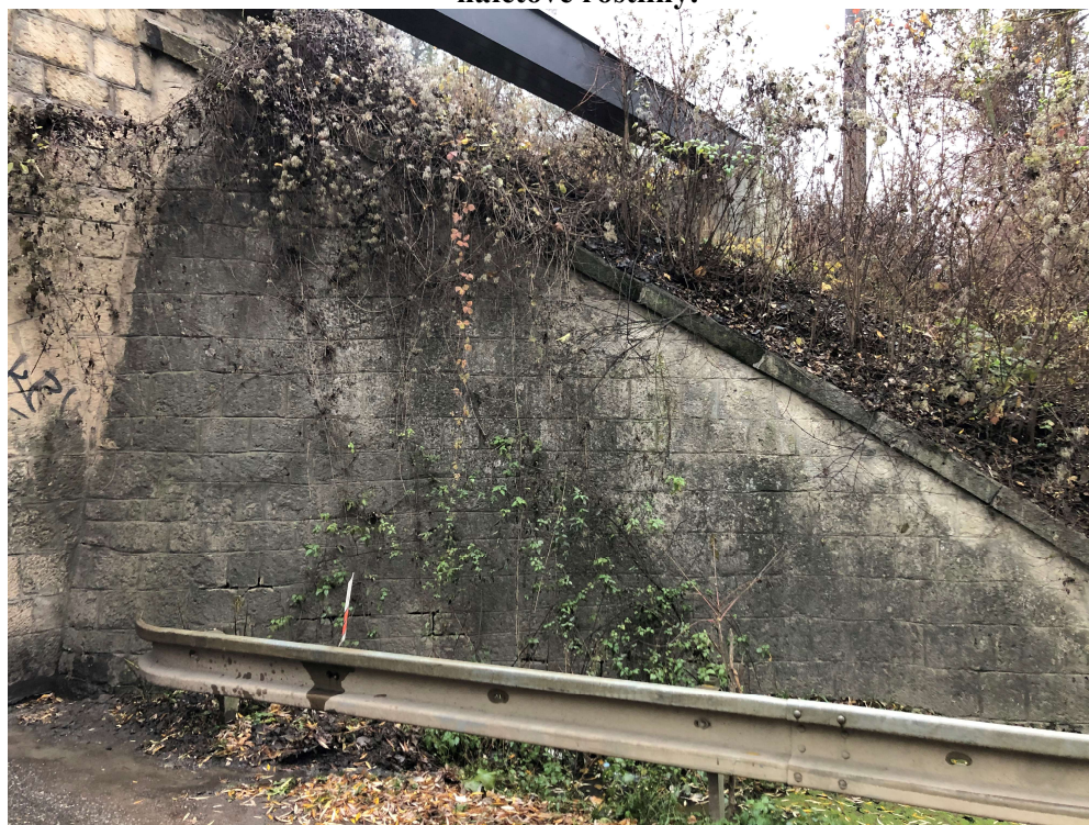
Fotografie č. 7: Pohled na pravé křídlo opěry ve směru na Brno hl. n. Místa degradované nebo vypadané spárování.
